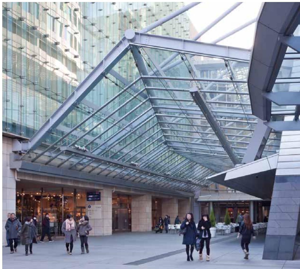
大屋根プラザ
